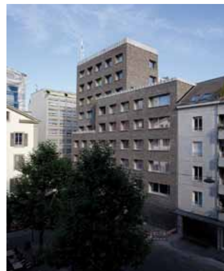
In zentraler Lage wird eine Restparzelle überbaut und dadurch Wohnraum für Studierende geschaffen: Studentenwohnheim, Genf, 2011, Charles Pictet Architects
